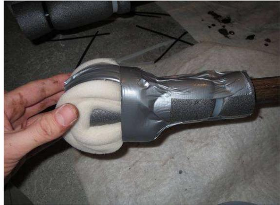
Nun den zweiten Streifen Schaumstoff um 90° gedreht ebenfalls symmetrisch nach hinten über die Rohrisolation kleben. Hier auf die Symmetrie achten:
